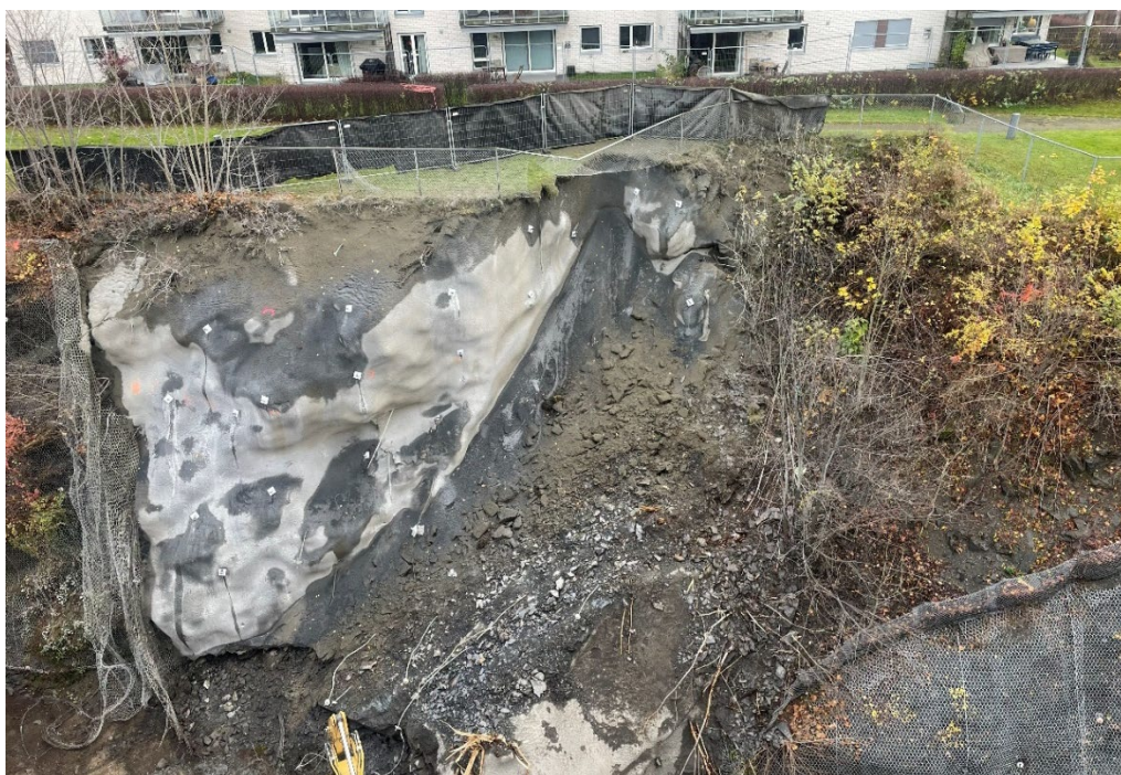
Figur 3-2 Skredområdet sikret med anviste ankerstag og fiberarmert sprøytebetong
